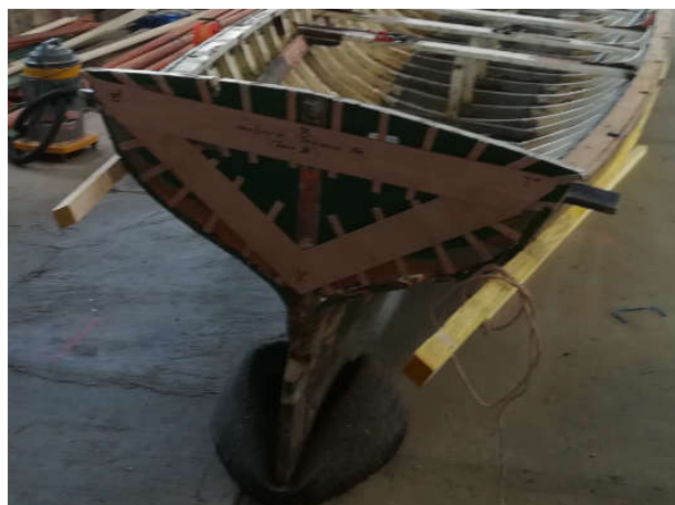
Un gabarit est pris sur tableau arrière
